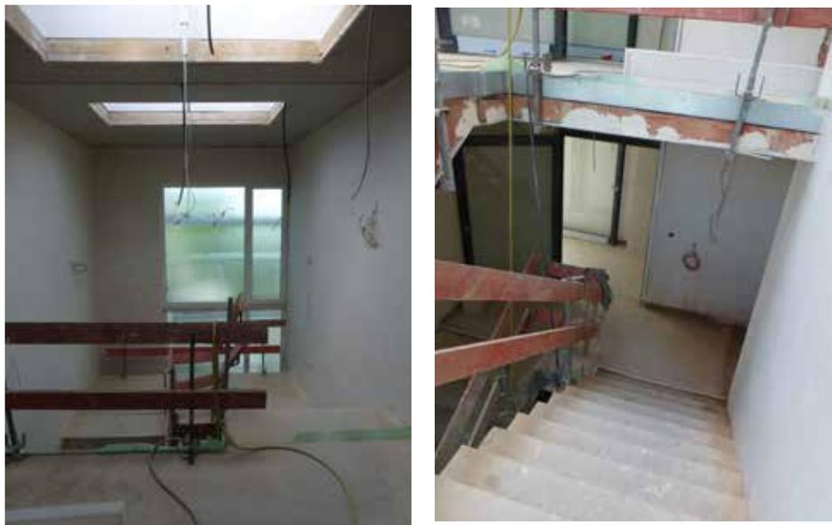
Der Ausbau der **Zimmer** schreitet voran. Im zweiten Obergeschoss sind bereits die Wände gestrichen, die Decken abgehängt, die Installationen gemacht und die ersten Fliesen in den Bädern angebracht worden.
