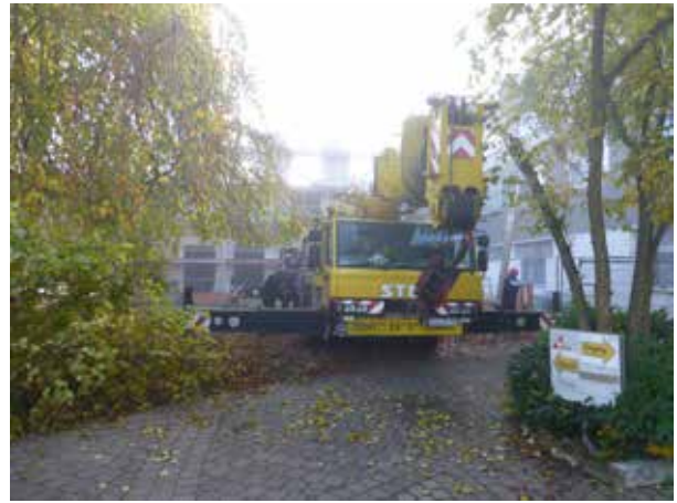
Kran zum Einbau Treppenhaus
