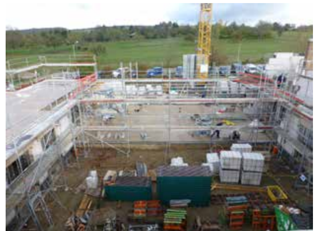
Innenhof und Bodenplatte Nord
