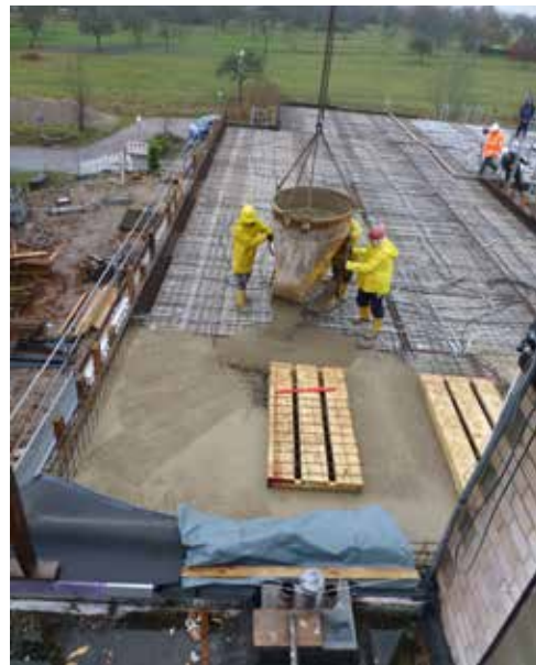
Decke 2 Obergeschoss West
