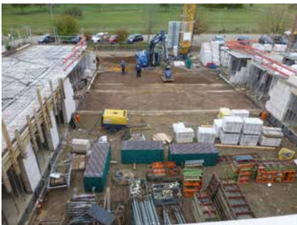
Innenhof und Fundament Nord
