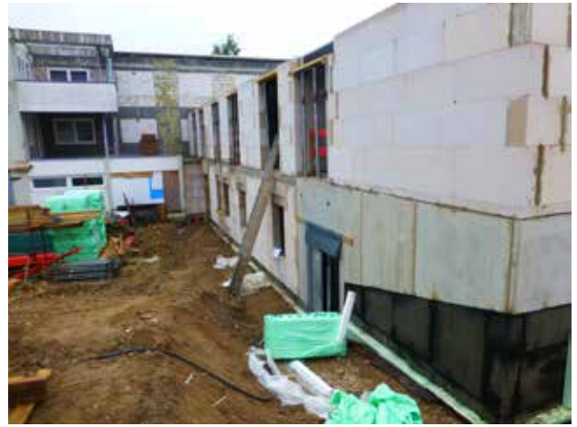
Erdgeschoss Technikraum u. erstes OG Ost
