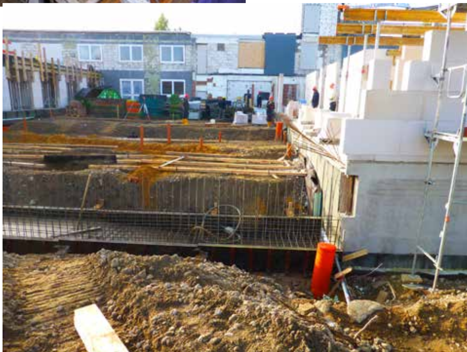
Das erste Stockwerk entsteht! Mit dem Mauerwerk im West- und Ostteil, sowie der Gründung des Nordteiles kann man die Größe der zukünftigen Anlage erahnen.
