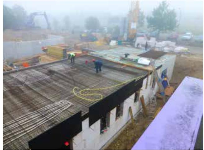
Die erste Decke wird vorbereitet und schon mit den Leerrohren für die späteren Kabel versehen.
