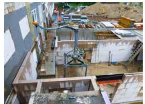
Kaum ist die Bodenplatte fertig sind auch schon die ersten Wände gestellt. In diesem Teil des Erdgeschosses entstehen der „Lieferanteneingang“, ein Raum für die Wäscherei, Lager, ein Raum für die Unterhaltsreinigung, die Werkstatt der Handwerker, die Umkleiden der Mitarbeiter und der zentrale Technikraum für Heizung und BHKW (Blockheizkraftwerk).
