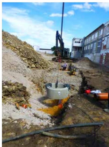
Bevor die eigentlichen Arbeiten mit Beton und Steinen beginnen, müssen die Grundleitungen verlegt werden. An dieser Stelle werden die Rohre für das Abwasser und das Regenwasser verlegt.
